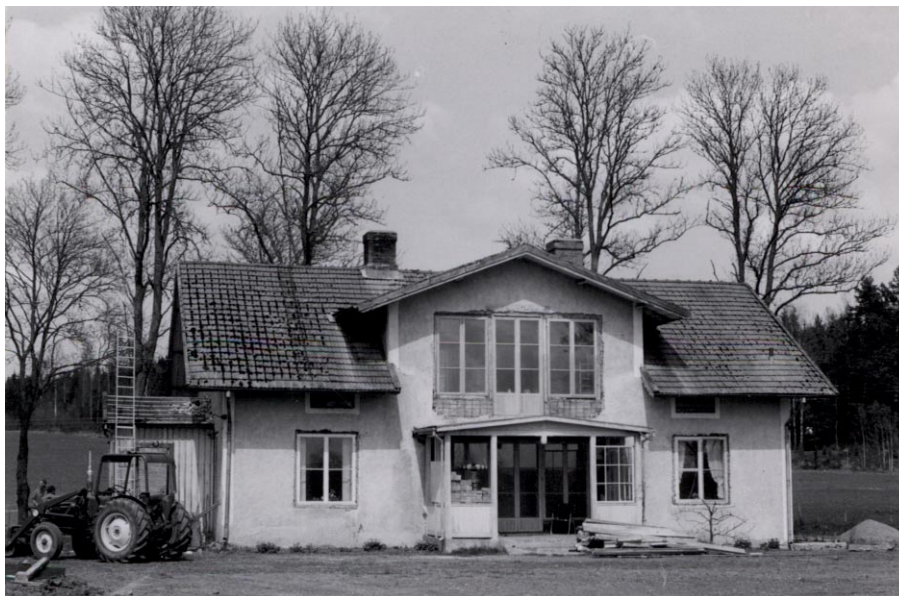
Byestad, norra flygel under ombyggnad 1965
